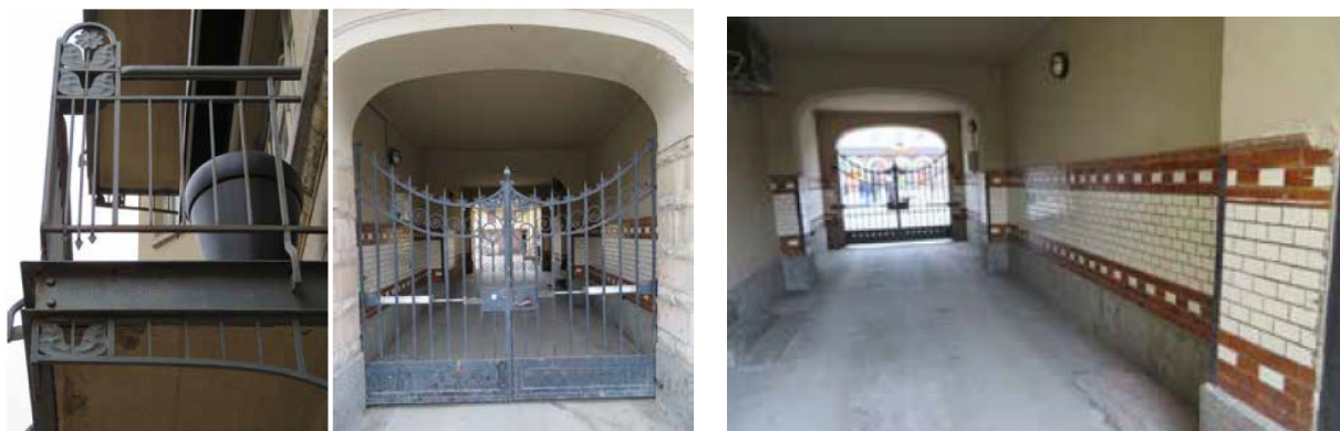
Bilder. Från vänster: smidesjärnsdetaljer i form av stiliserade blommor på balkonger, smidesjärnsgrind mot innergården och utfart från innergård till S:t Larsgatan utformad med klinker (WSP 2017).
