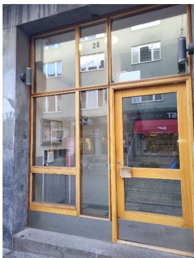
Bild. Ursprunglig port med portal vid Nygatan 28 (Linköpings kommun).
