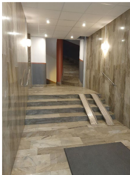
Bild. Entréhall Doppingen 15 lågdel (Linköpings kommun).
