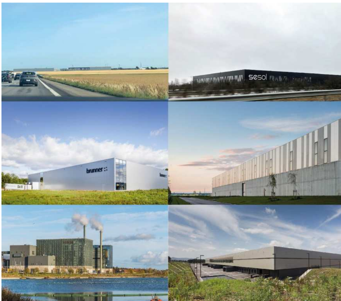
Exempel på storskaliga byggnader som tonar in i landskapet genom naturnära färger.
