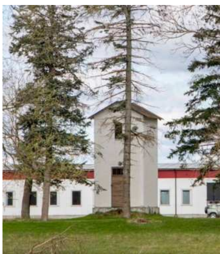
Transformatorstation vid Staby säteri
