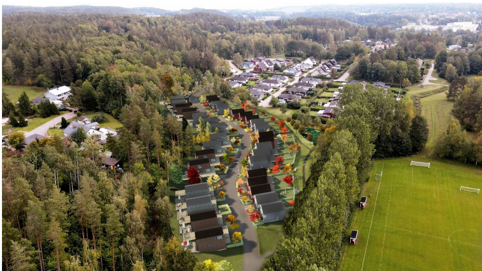
Nya småhus grupperas i längor bestående av 4-7 hus. Fotomontage av SM2L Arkitektur & Urban Design AB.
