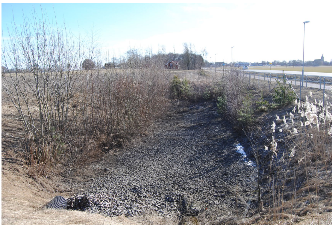
Bilden ovan visar befintlig dagvattendamm på planområdet.
