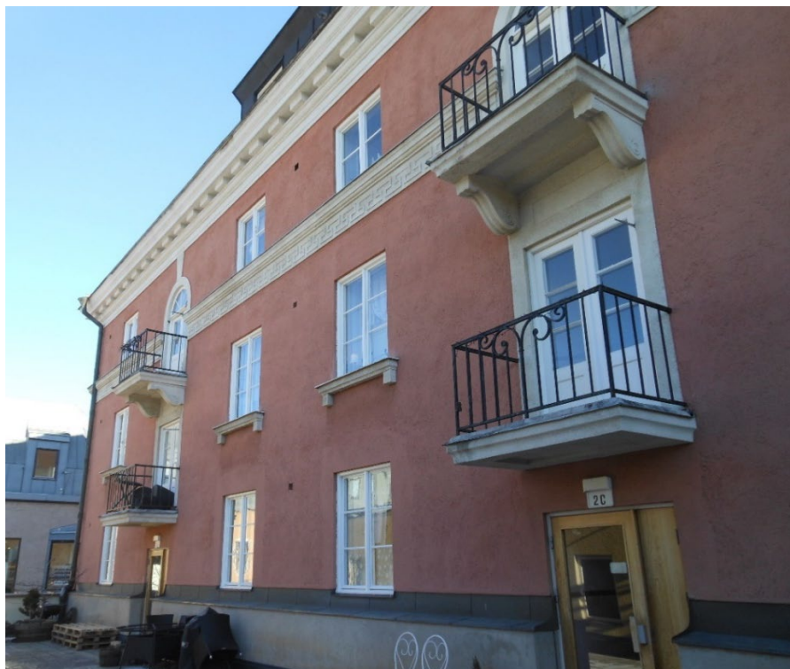
Del av Delfinpalatsets fasad mot innergården.
