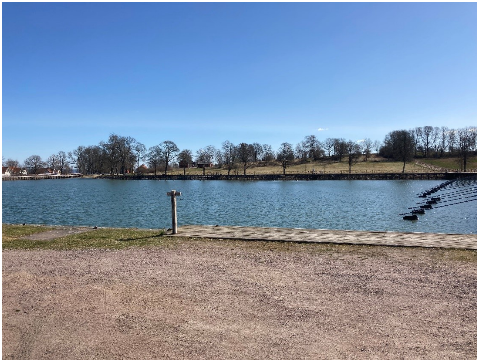
Figur 12. Vy västerifrån, med hamnbassängen i förgrunden och den karaktäristiska drumlinen i fonden.
