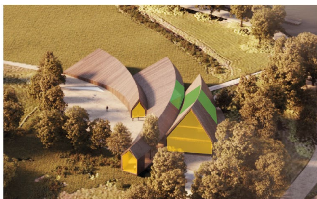
Bild. Illustration som visar hur gavlarna kan vara uppglasade (gul kulör) och förslag på placering av öppningar i tak- och fasad (grön kulör). Bilden illustrerar en princip och inte det slutliga förslaget. Illustration Tengbom.
