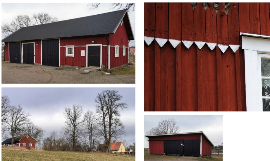
Bild. Komplementbyggnaderna som tillhör Carl-Johans slussvaktarbostad, en fd ladugård och ett garage. (Bilder från kulturmiljöutredningen, Arkeologerna, rapport 2021:1)
