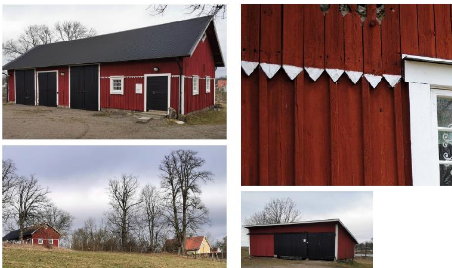
Bild. Komplementbyggnaderna som tillhör Carl-Johans slussvaktarbostad, en fd ladugård och ett garage. (Bilder från kulturmiljöutredningen, Arkeologerna, rapport 2021:1)
