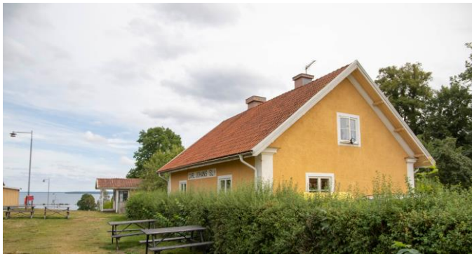
Bild. Carl-Johans slussvaktarbostad, utanför planområdet. Komplementbyggnaderna har tillhört detta boställe.
