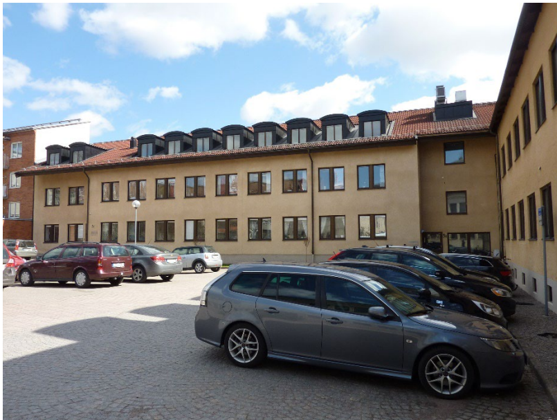
Kontorsbyggnaden med infart från Hertig Karlsgratan, från innergården sett.
