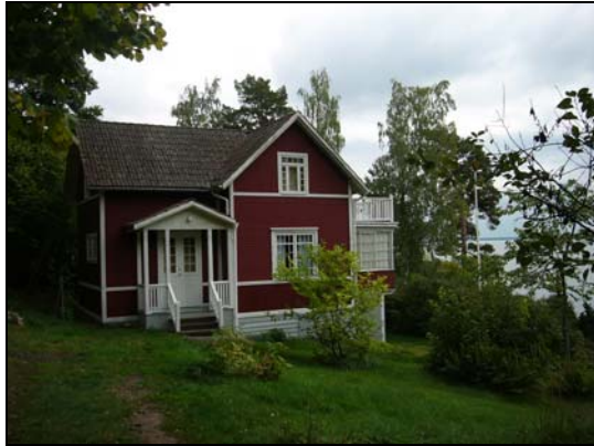
Roxenbaden 1:6, Sjöhyddan från 1904 med en traditionell rödmålad fasad med stående och liggande fasspontpanel. Under den nuvarande röda färgen återfinns en faluröd färg. Taket har bevarat sin originalbeläggning med tvåkupigt lertegel. Claryshof på Korsvik 1:8 har stående och liggande fasspontpanel målad i en ljusgul färg.
