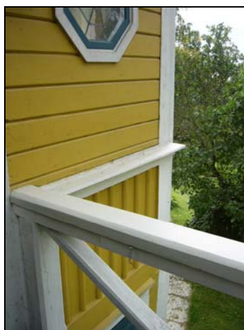
Sandvik 1:58 från början av 1960-talet med sk stockpanel, rundhyvlad plank med brun originalfärgsättning under den nuvarande röda färgen. Liggande fasspontpanel samt locklistpanel på Ekviken från 1906 på Korsvik 1:10.
