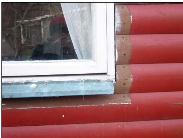
Sandvik 1:58 från början av 1960-talet med sk stockpanel, rundhyvlad plank med brun originalfärgsättning under den nuvarande röda färgen. Liggande fasspontpanel samt locklistpanel på Ekviken från 1906 på Korsvik 1:10.
