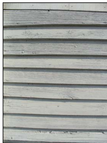
Sommarstugan på Sandvik 1:45 är uppförd 1963 med bevarad originalfärgsättning samt tidstypisk s k panel på förvandring. Detalj av panel på förvandring på Villa Idet, Roxenbaden 1:6, uppförd 1911.
