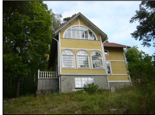
Roxenbaden 1:6, Sjöhyddan från 1904 med en traditionell rödmålad fasad med stående och liggande fasspontpanel. Under den nuvarande röda färgen återfinns en faluröd färg. Taket har bevarat sin originalbeläggning med tvåkupigt lertegel. Claryshof på Korsvik 1:8 har stående och liggande fasspontpanel målad i en ljusgul färg.
