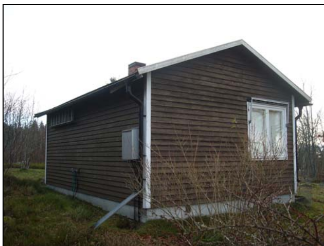
Sommarstugan på Sandvik 1:45 är uppförd 1963 med bevarad originalfärgsättning samt tidstypisk s k panel på förvandring. Detalj av panel på förvandring på Villa Idet, Roxenbaden 1:6, uppförd 1911.
