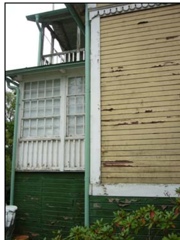
Pärلسpontpanel på lekstugan, Claryshof, Korsvik 1:8. Faluröd färg skymtar under den nuvarande gula färgsättningen på Hasselbacken, Korsvik 1:22.
