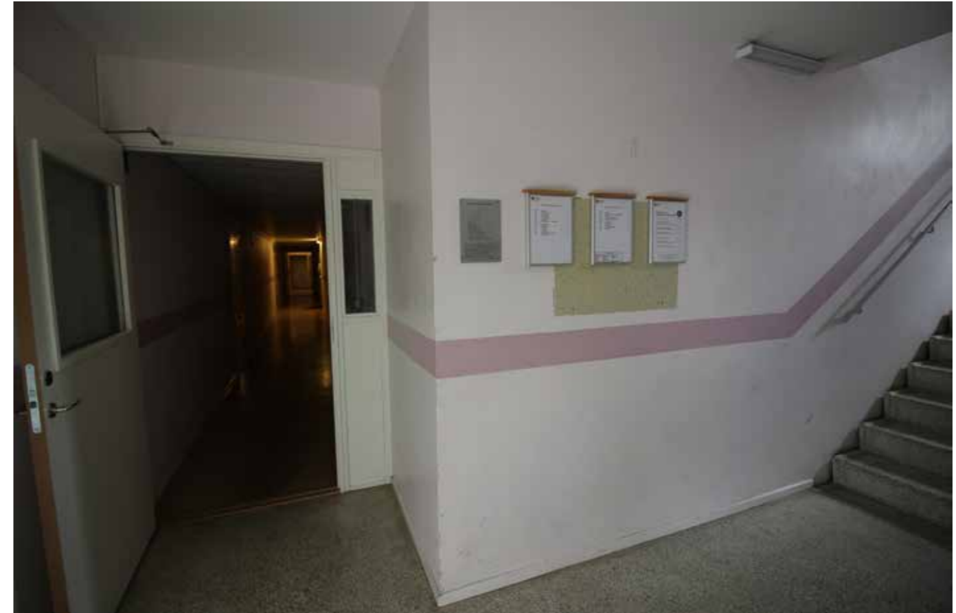
Trapphus i den västra flygelbyggnaden. Terazzogolv och väggar i ljusrosa med en mörkrosa bård, troligtvis originalutförande från början av 1970-talet. Dörren till studentkorridoren är troligtvis utbytt på 1980-90-talet.
