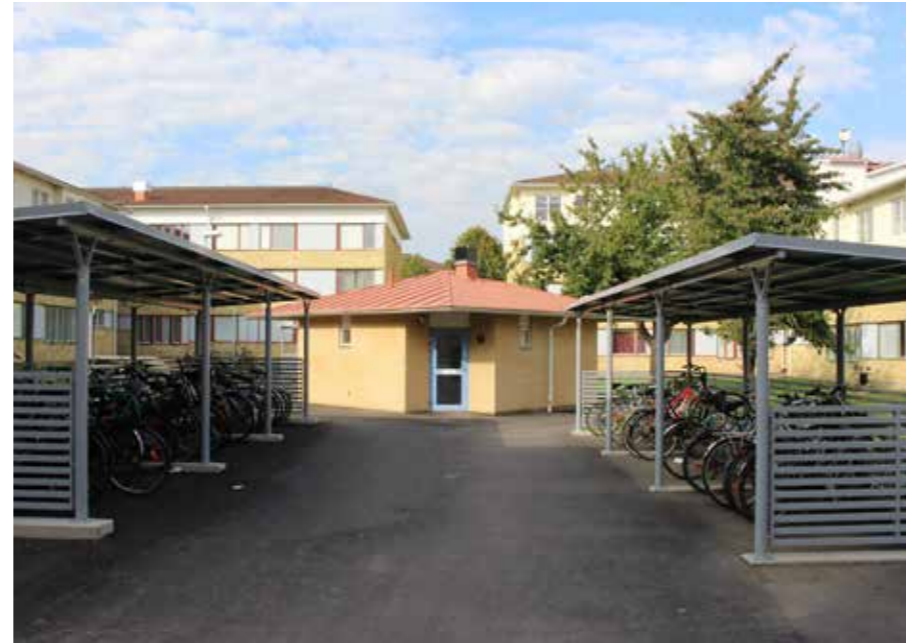
Nya taktäckta cykelparkeringar från 2016 och tvättstuga från slutet av 1980-talet.
