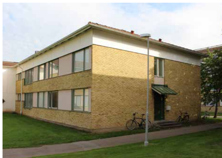
De lägre bostadshusen i kvarterets mitt har inget påbyggt våningsplan men de platta taket har ersatts av tegelklädda sadeltak.
