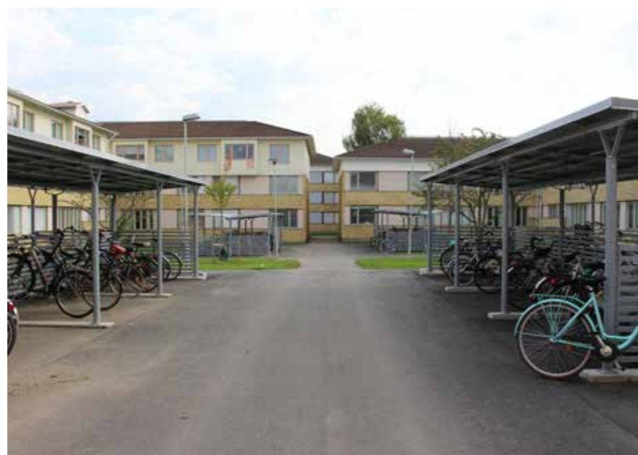
Gårdsstråk med nyligen anlagda cykelgarage på var sida.
