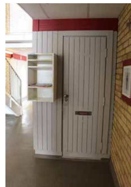
Ursprungligt posttrum med panel och dörr klädd i träpanel i entrévåningen.
