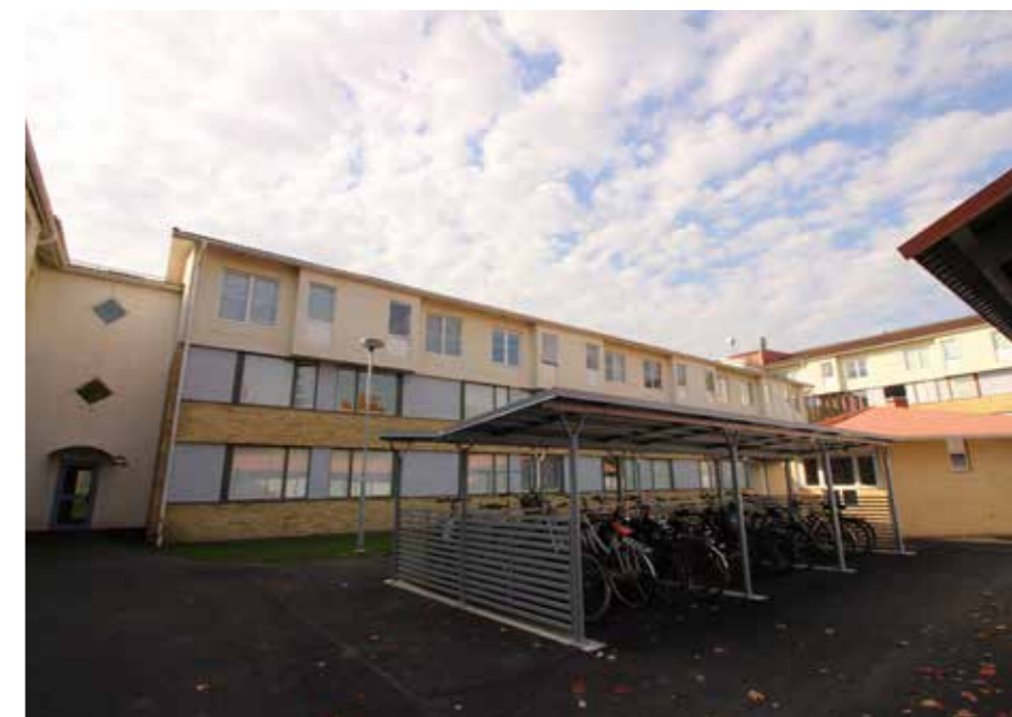
De halvslutna gårdarna i kvarterets ytterkanter är till stor del asfalterade och präglas av servicefunktioner i form av cykelparkering, tvättstuga och förrådsbyggnader.
