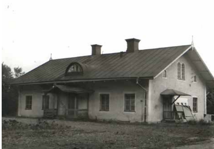
Den f.d. herrgårdsflygeln uppfördes runt 1890 som revs i samband med studentbostädernas utbyggnad.
