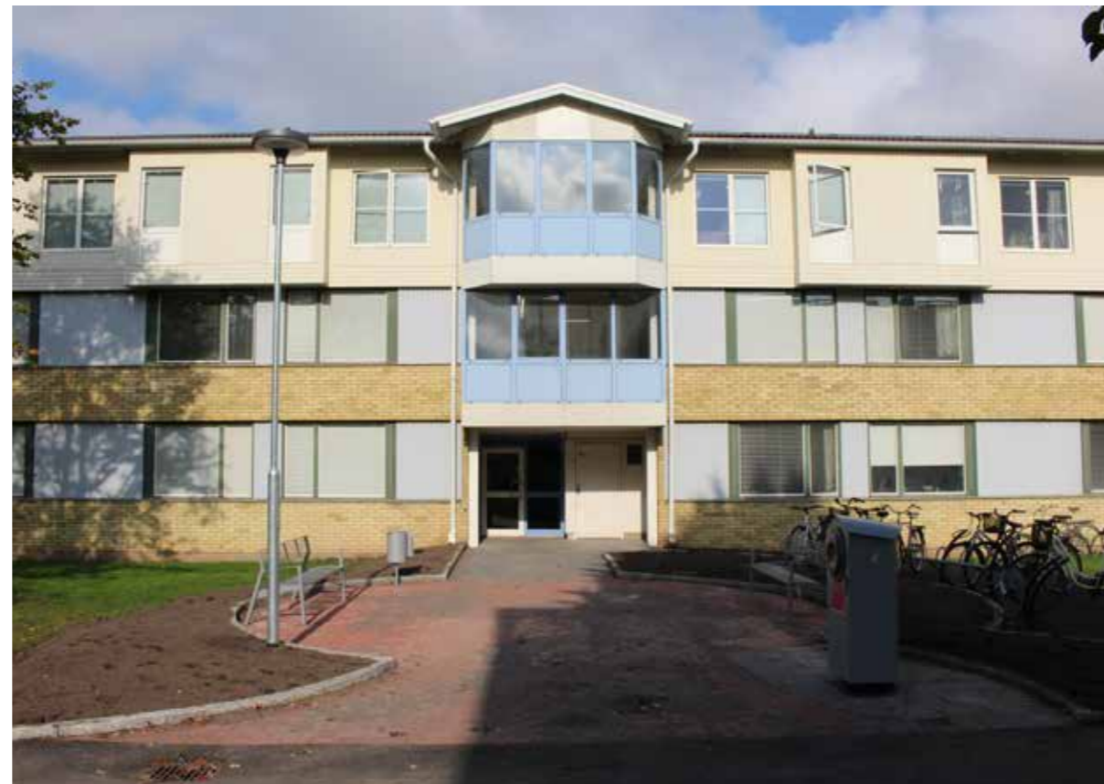
I slutet av 1980-talet påbyggdes husen med ett våningsplan och burspråk mot gatufasaden. Entréer och trapphusfasaden fick en ny utformning. Utemiljön genomgår i skrivande stund en upprustning bl.a. i form av ny markbeläggning, planteringar och bänkar.
