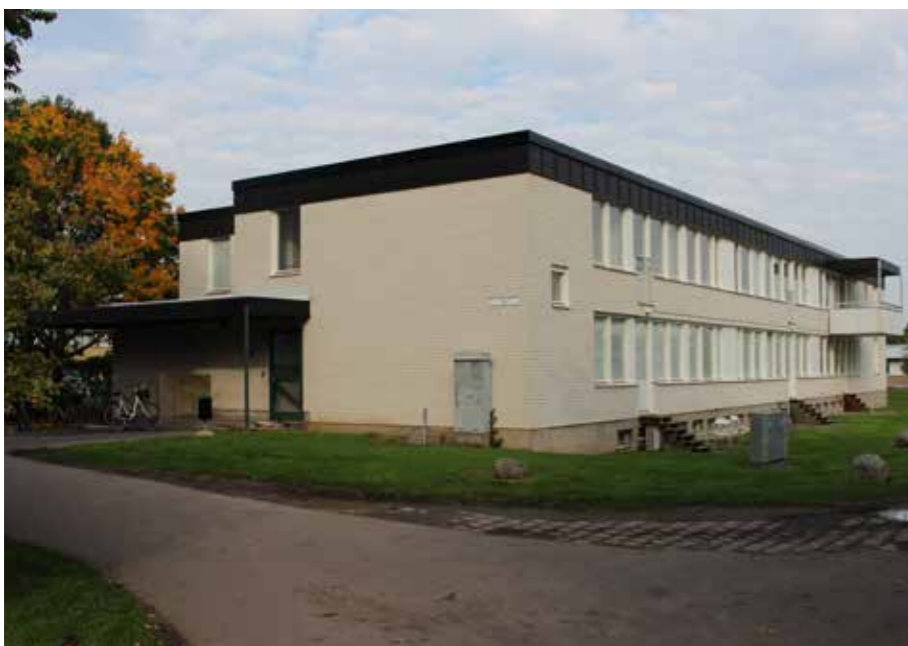
De två vinkelställda "flygelbyggnaderna" uppfördes 1971 och har en avvikande utformning gentemot övriga byggnader inom kvarteret med fasader av vitt mexitegel och takband av plåt.
