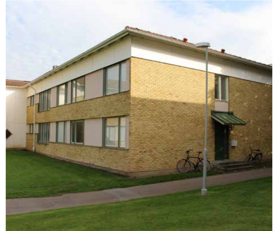
Ursprungliga skärmtak och entréportar på gavlar på de lägre tvåvåningshusen i kvarterets mitt.
