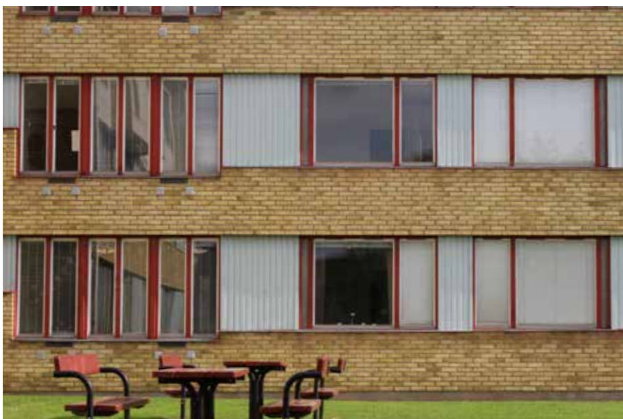
Fasaden mot gården har fönsterband och tvåluftsfönster med sidoförskjuten bäge. Mellan fönstren finns partier av plåtpanel.
