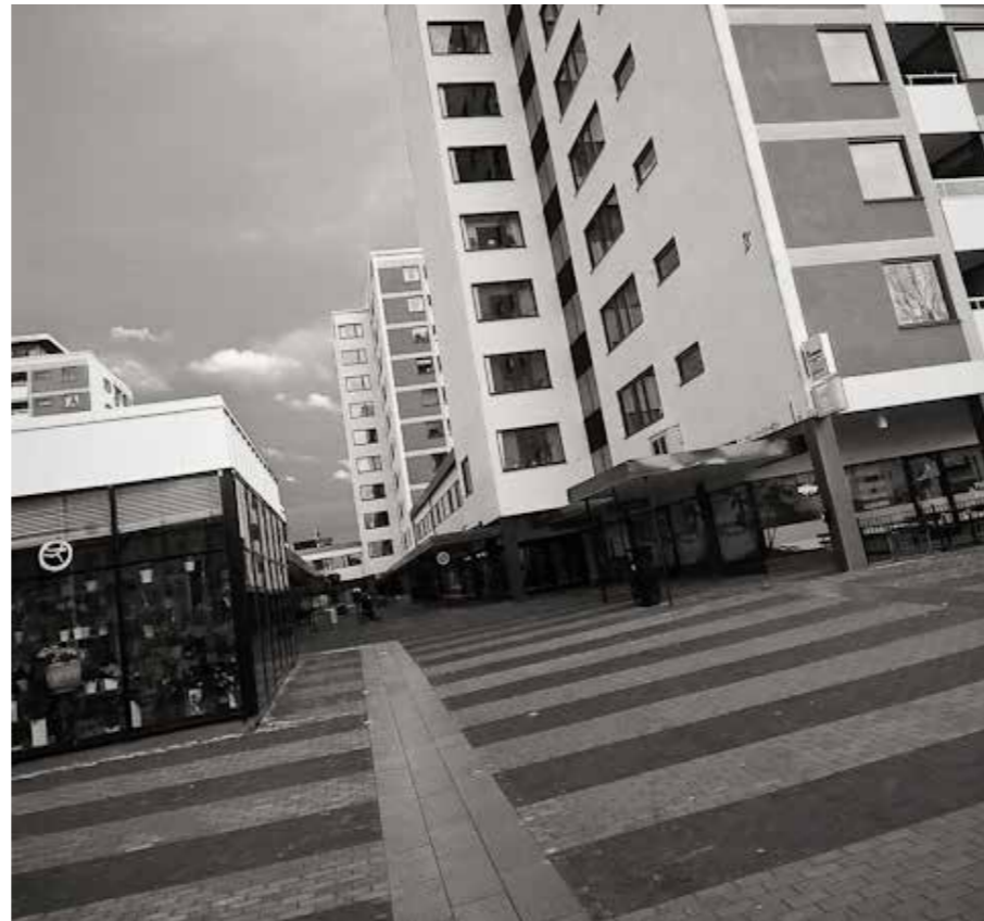
Johannelund var Linköpings första stora byggnadsprojekt. Utbyggnaden startade 1955 och den nya stadsdelens centrumbebyggelse invigdes fem år senare efter Höjer-Ljungqvist ritningar. Källa: Digitalt Museum.
