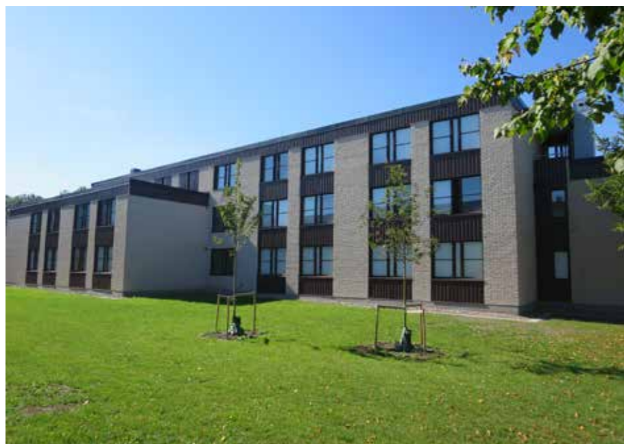
Område F (Kv. Ostfatet) i sydvästra delen av Ryd, söder om Ryds centrum. De 11 volymerna har lika utformning med en högre förskjuten volym i tre våningar sammanbyggd med en lägre del i två våningar. Husen har genomgående fasader av mexitegel med fönsterbröstningar och takfot av brun plåtpanel.
