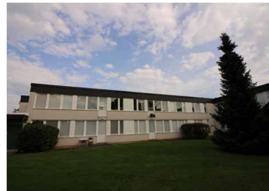
Den östra flygelbyggnaden sett från gårdssidan. Fönstren är grupperade i fönsterband. I övre våningsplanet finns franska balkonger och under dessa finns entrédörrar från gården.
