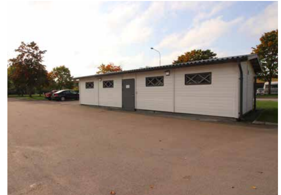
På parkeringsplatserna finns miljöhus som tillkom 2005. Miljöhusen har vitmålade fasader med liggande träpanel, korrugerat plåttak och fönster med kryssformad spröjs.
