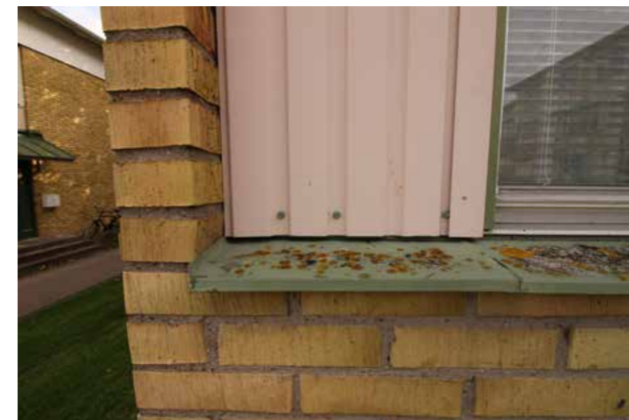
Fasadpanelerna som sannolikt var i trä ursprungligen har utbytt till plåtpaneler.
