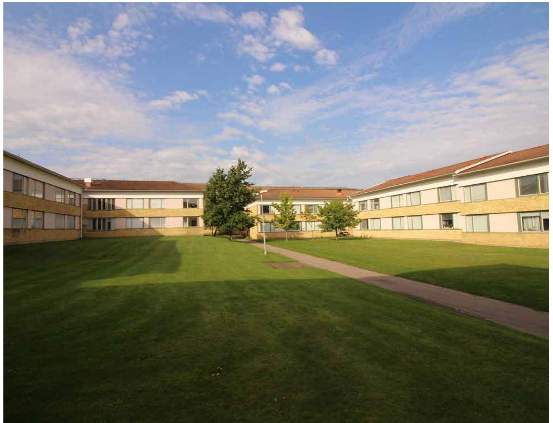
En av de kringbyggda bostadsgårdarna som saknar tvättstuga och cykelgarage.
