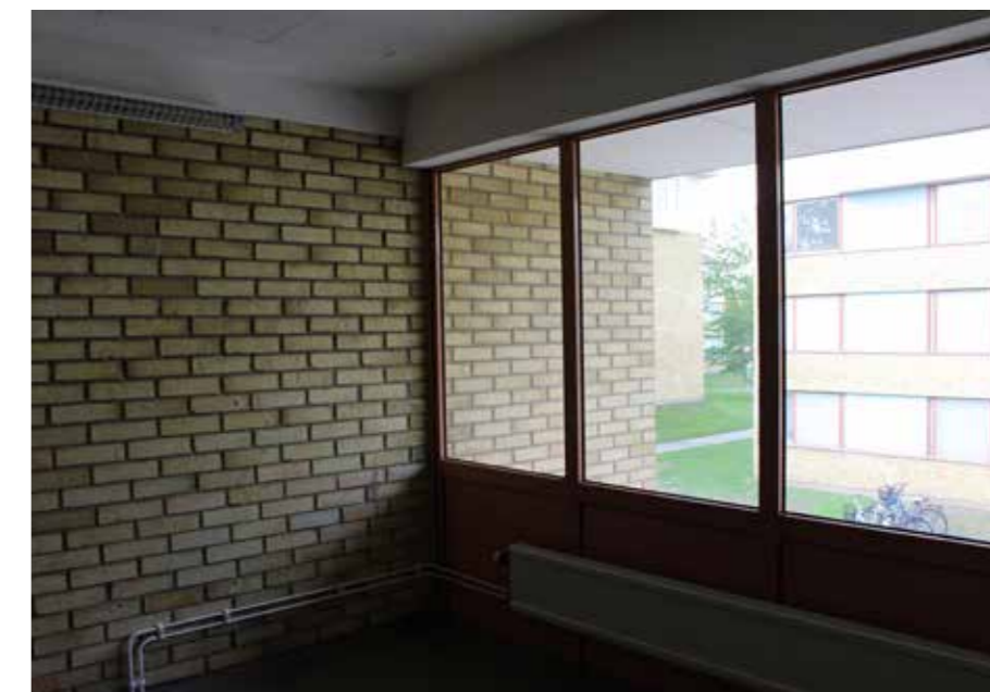
I trapphuskorridoren mot gatufasaden finns stora fönsterpartier med bröstning och karmar i aluminium som tillkom i samband med ombyggnaden i slutet av 1980-talet.
