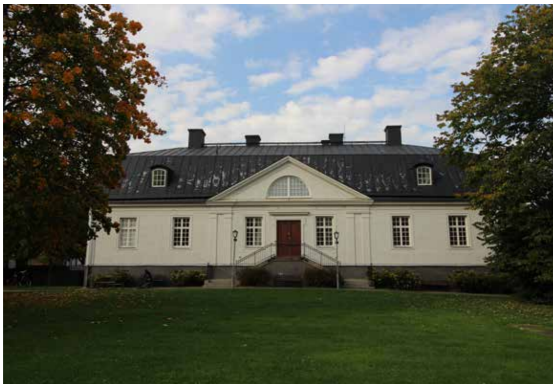
Herrgårdsbyggnaden och den stora gräsplanen bildar en front mot söder mellan Ryds centrum och Ostkupans studentbostäder.
