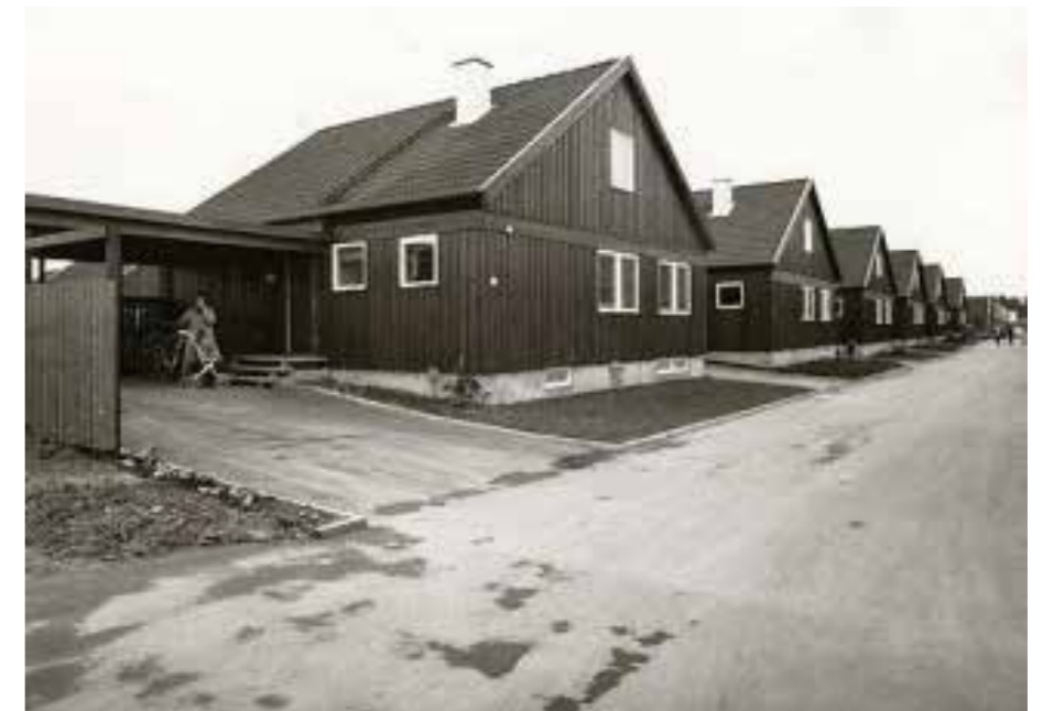
Småhusområdet Ryd A på 1970-talet. På bilden syns de så kallade KB-villorna ritade av det lokala byggbolaget Kvissberg & Bäckström AB. Bildkälla: Linköpingshistoria.se
