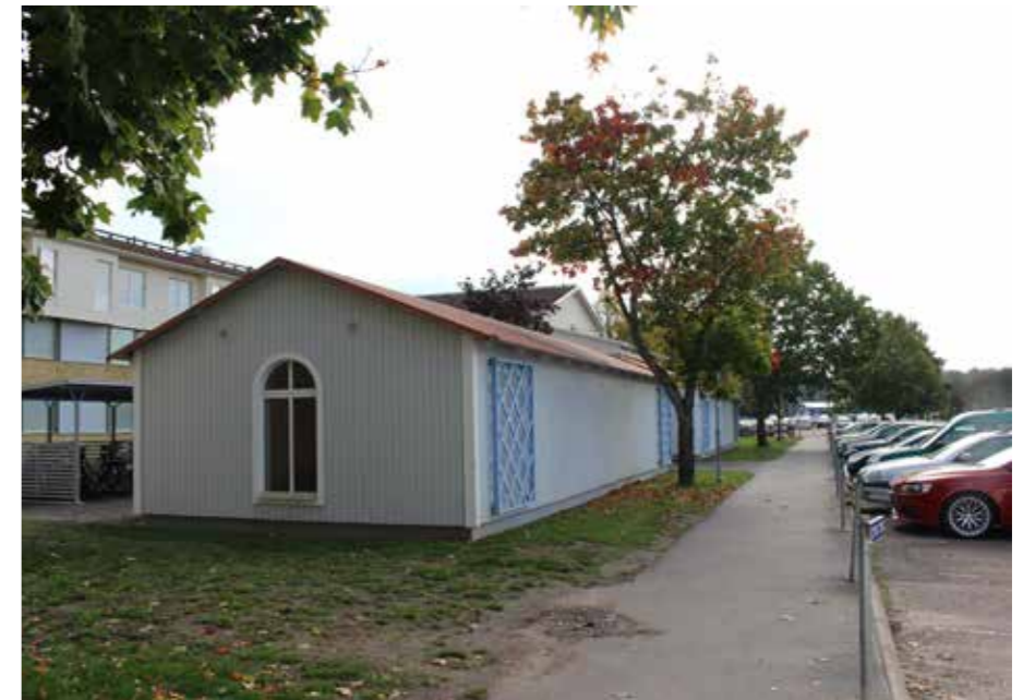
Förrådsbyggnaderna på gården har stående träpanel i ljus grått, korrigerat plåttak och rundbågade fönster på gavlarna.
