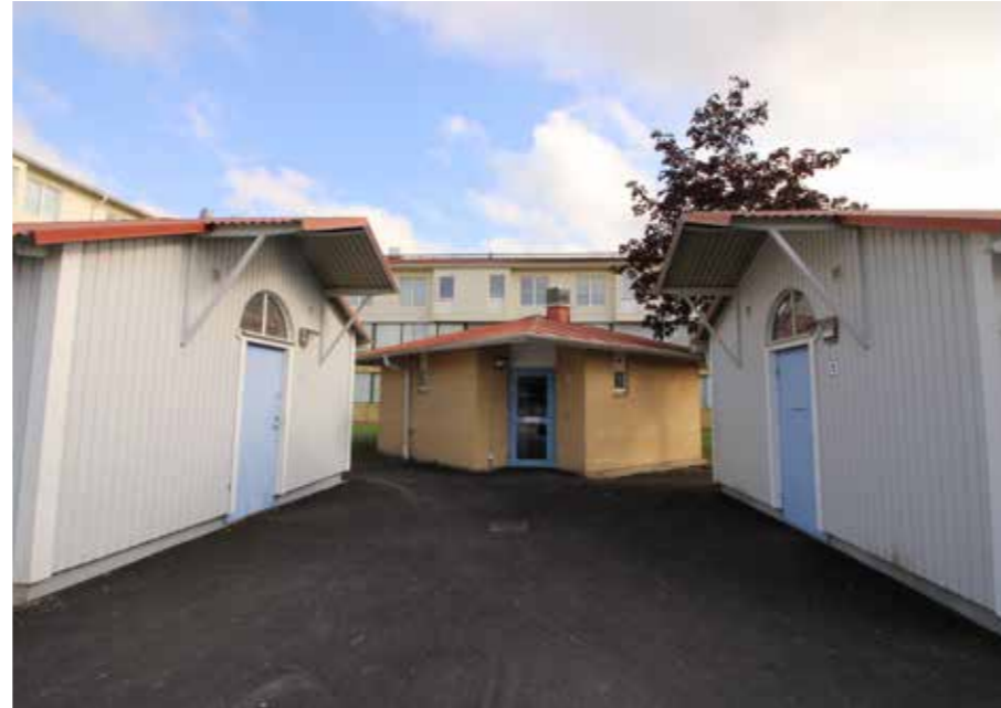
Förrådsbyggnader och tvättstuga tillkom under 1980- och 90-talet.
