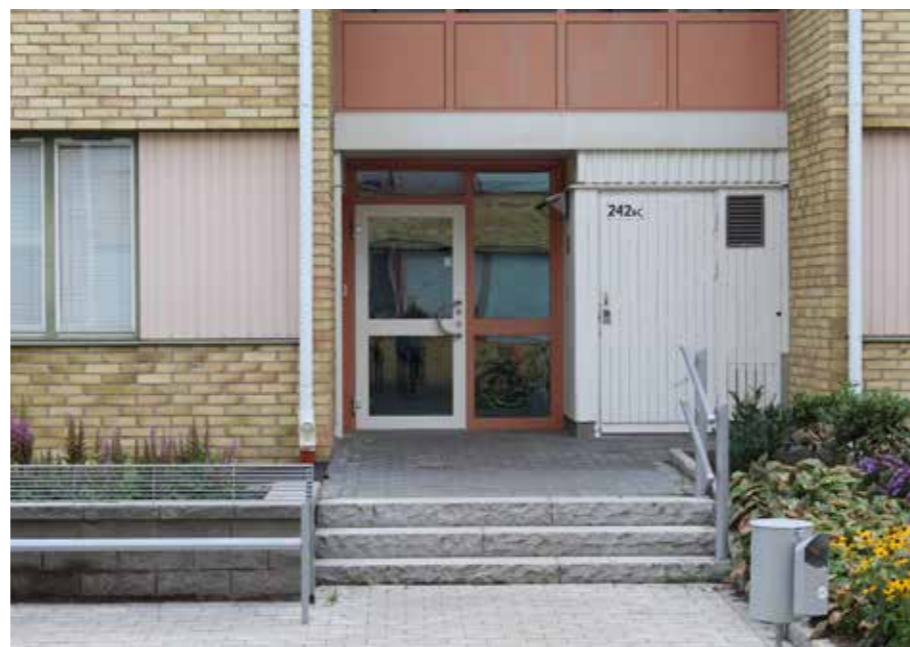
Nya murar med planteringar vid entréerna har nyligen tillkommit som en del av upprustningen av kvarterets utemiljö.
