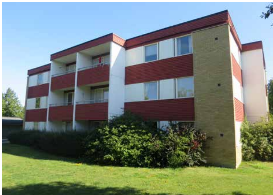
Studentbostäder i Område E i kv. Osthyveln väster om kv. Ostkupan. Dessa punkthus är 12 st i antal och placerade i grupperingar om tre. Fasader i gult tegel och fasaband i stående och liggande träpanel (?) i vit och rött/grönt.
