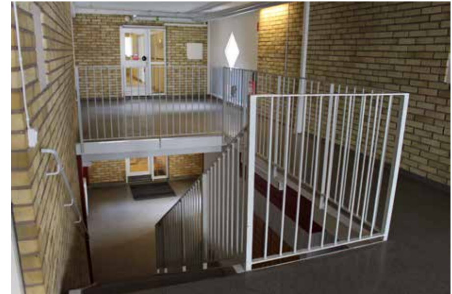
Våning 1 tr. Trappräcke och ledare i vitmålat stål. Färgbortfall visar att räcket tidigare varit grönt.
