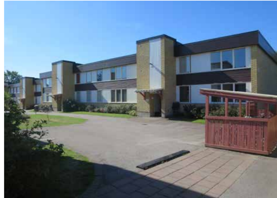
En av hustyperna i Område D i västra delen av Ryd. Husen ritades av SAR Audun Stockland från Göteborg med tydlig inspiration från Område C med låga lamellhus, utskjutande trapphuspartier med indragen entréport, fasad- och takband i liggande mörkt brun träpanel och gavlar och trapphus i gult tegel. I område D saknas Ostbrickans utskjutande gavelpartier, här är istället takbanden något utkragande från fasaden.
