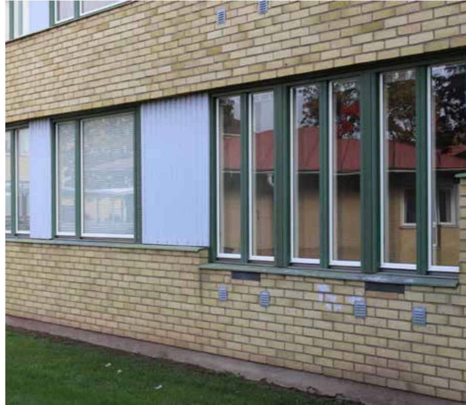
Ursprungliga tvåluftsfönster samt enluftsfönster med upprepad fönstersättning i fönsterband i byggnadernas ursprungliga våningsplan.
