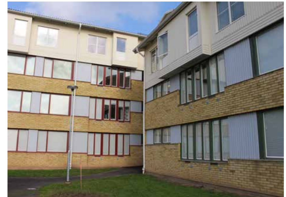
Gärdsfasad i kvarterets västra del.
