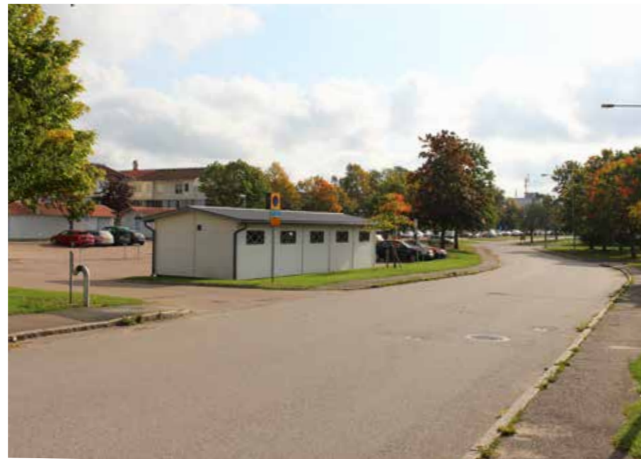
Alsättersgatan mot söder. Markparkeringar och förrådsbyggnader i kv. Ostkupan till vänster. På höger sida finns område D med familjebostäder.
