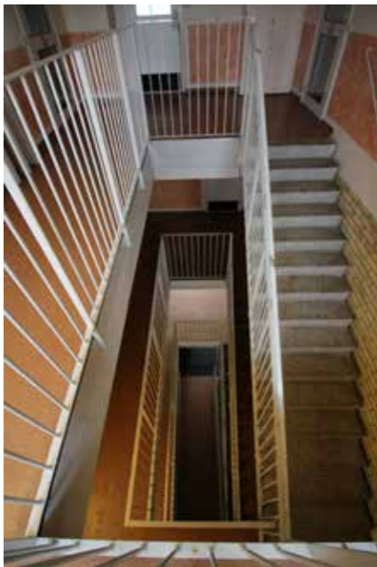
Trapphuset sett från det övre påbyggda våningsplanet. Trappräcke och ledare i vitmålad stål i likhet med nedre våningsplan.
