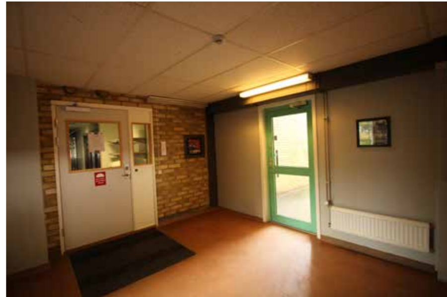
Del av bottenvåningen i passagen mellan husvolymerna. Trapphuspassagen tillkom i slutet av 1980-talet, troligtvis utbyttes dörrarna till studentkorridorerna samtidigt. Den gröna dörren leder ut till gården.
