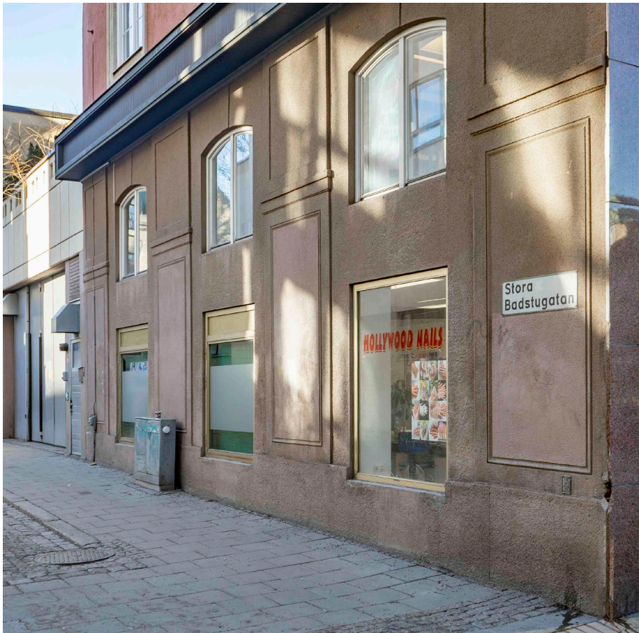
Delfinpalatsets södra gavel med välbevarade grova putsfält och släta arkadmotiv i byggnadens sockelvåning.
