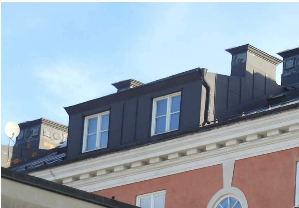
Vindslägenheternas befintliga takkupor med vita, spröjsade träfönster med mittpost.
