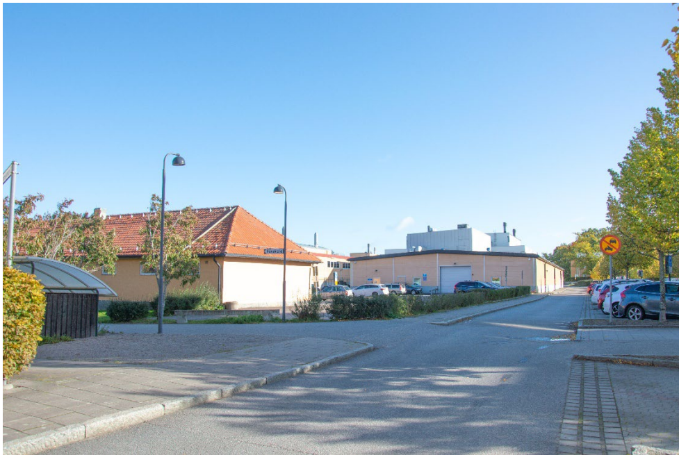
Bilden visar hur den östra stallbyggnaden ser ut idag, sett från sydväst. (Winell & Jern arkitekter)
