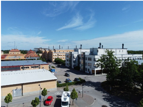
Bilden visar hur utsikten ser ut idag med den befintliga förrådsbyggnaden längs med Kompanigatan, sett från söder och mot nordöst. Fotot är taget från cirka 15 meters höjd. (Linköpings kommun och Winell & Jern arkitekter)
