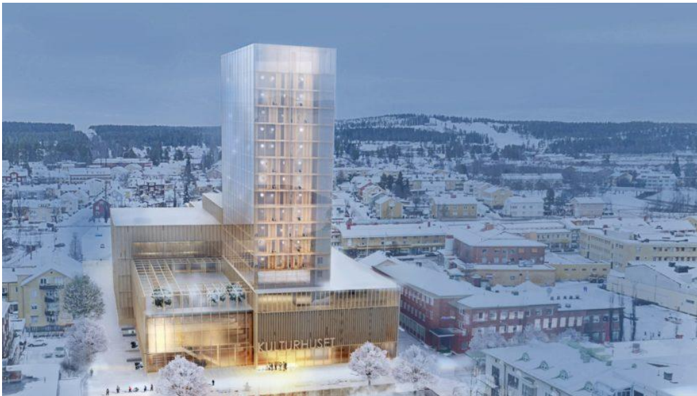
Figur 23. Sara kulturhus i Skellefteå, som beräknas vara klar under 2021. Källa: White arkitekter.
