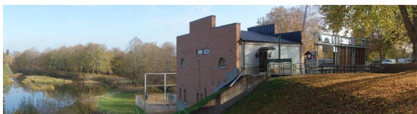
Vy över Odenfors kraftstation inom karaktärsområdet.
