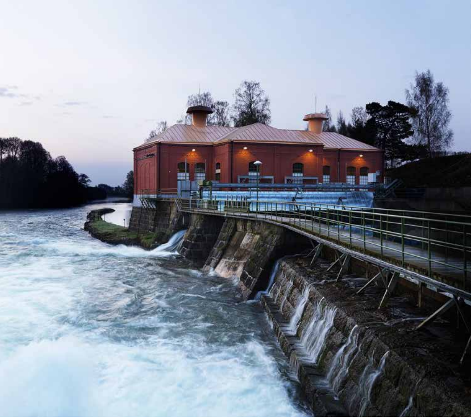
Nykvarn vattenkraftverk i Linköping Foto: Tekniska verken
