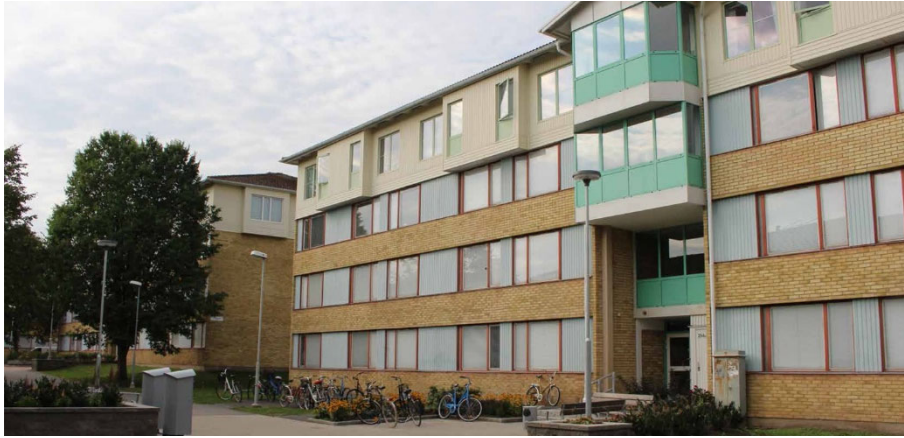
Bild på befintlig bebyggelse från 60- talet, som byggdes på under 80- talet.
