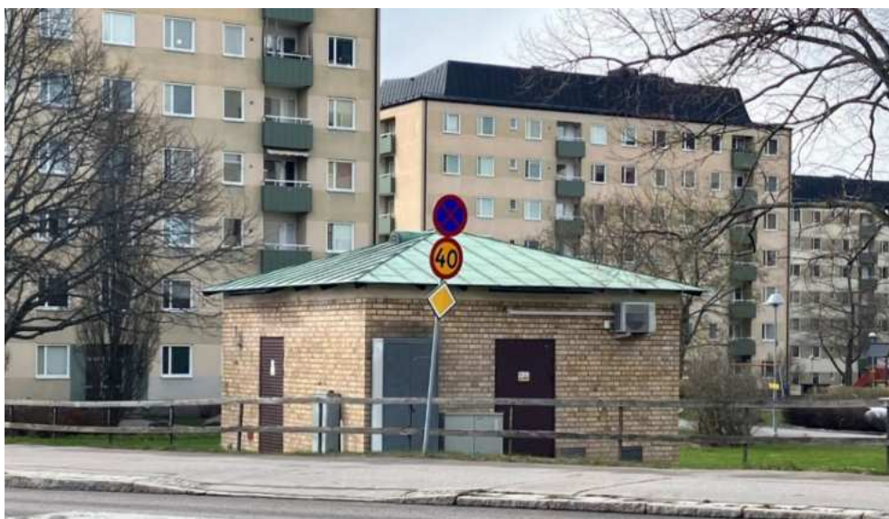
Elnätstation på fastigheten Lagerkransen 2. Bild tagen från Söderleden.
