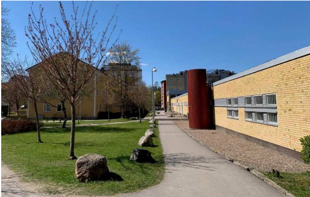
Baksidan av befintlig centrumbyggnad och grönyta på Laken 4.
