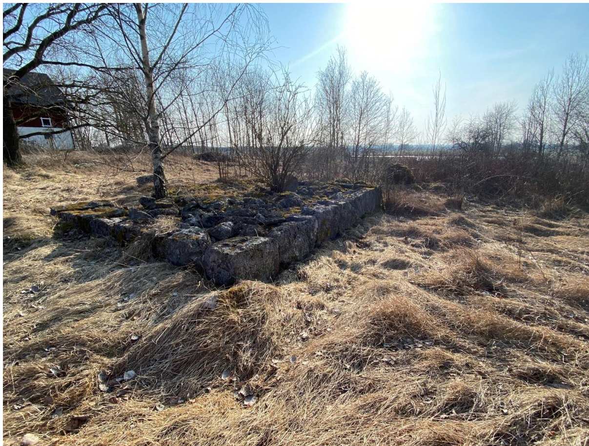
Figur 6. Husgrund (Reg. 63). Fotograferad mot väster. Foto: Norconsult AB.
